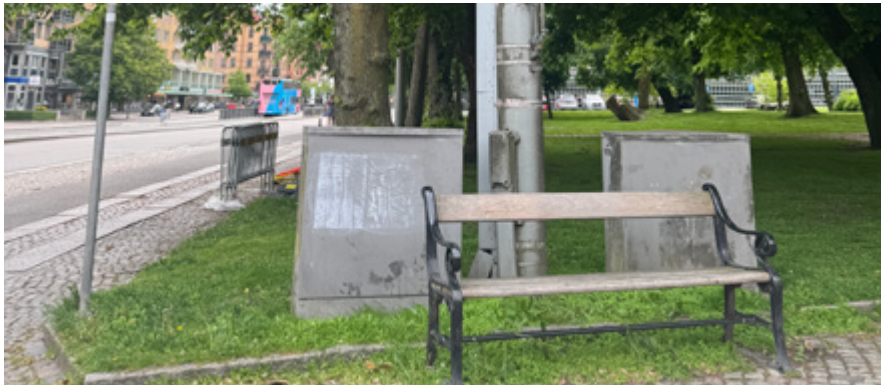
Två elskåp vid entré till Lorensbergsparken.
