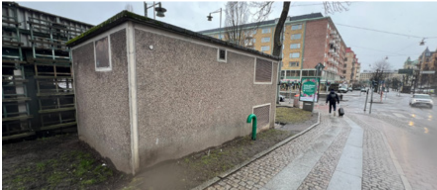
Transformatorstation och fjärrvärme vid Berzeliigatan.
